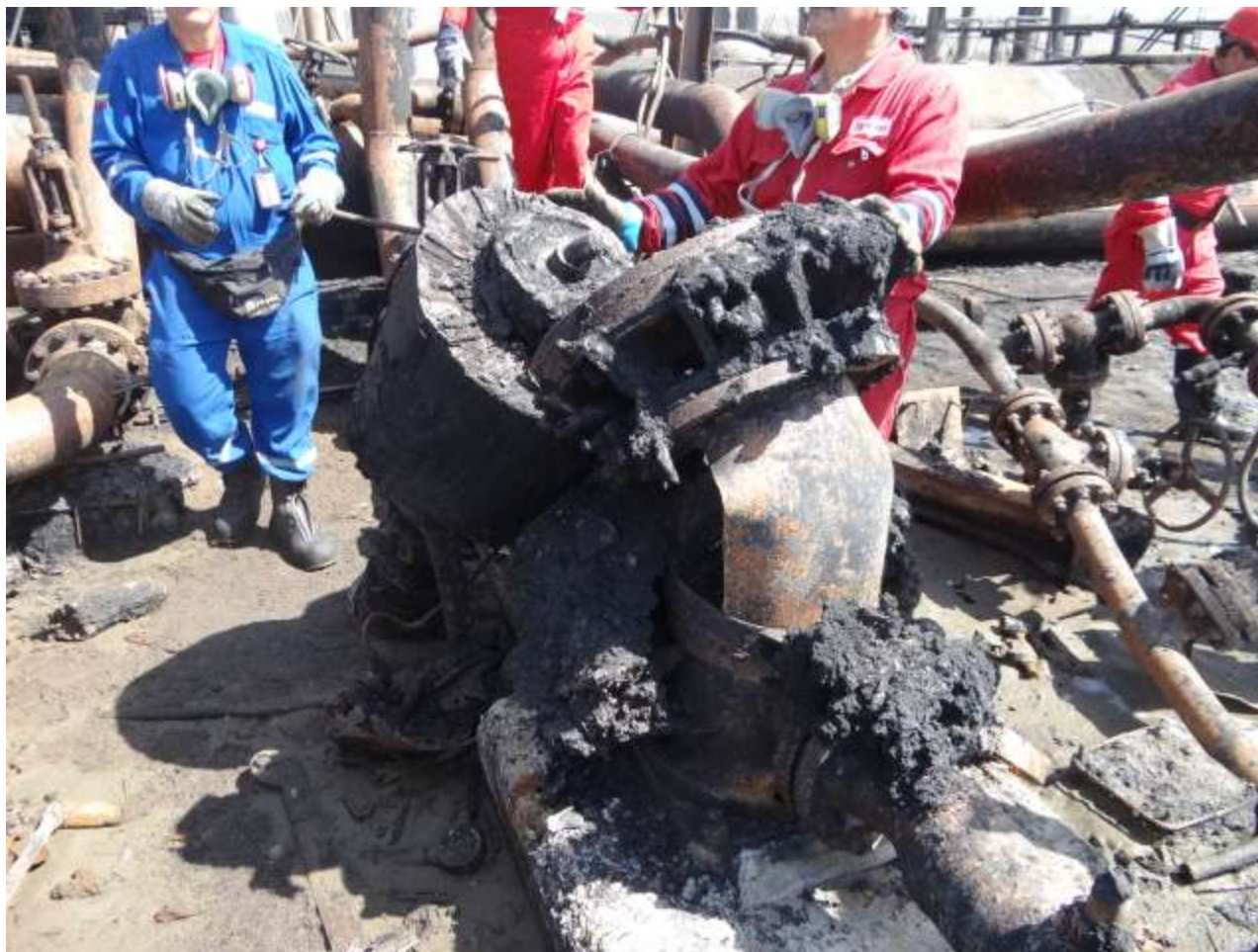
Muestra N°15. Bomba P-2601 y su Motor.
