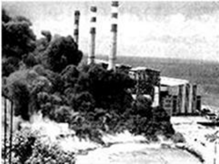
Foto N° 2 - El combustible incendiado rodeó la planta hasta el muro de protección perimétrica, logrando alcanzar la playa y al mar. Los tanques N° 8 y N° 9 estaban a la izquierda de la fotografía. Foto del 19/12/1982, minutos después de la sobrebullición.
