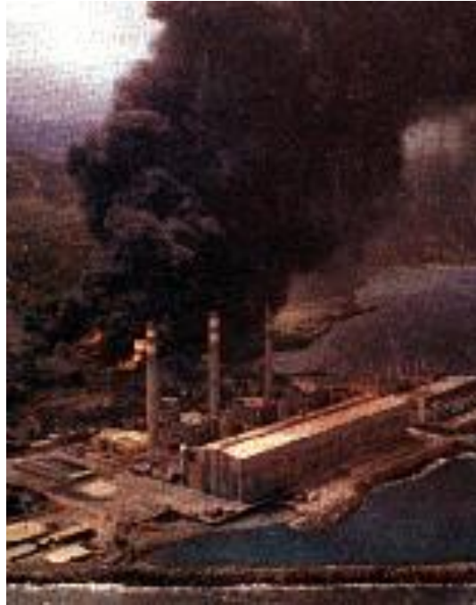
Foto N° 3 - Incendio confinado al tanque N° 9 el 20 de diciembre de 1982, un día después de la sobre-ebullición.
